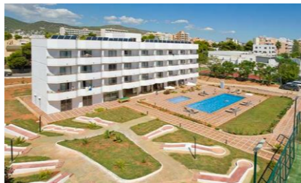
Appartements Bon Sol, Espagne
